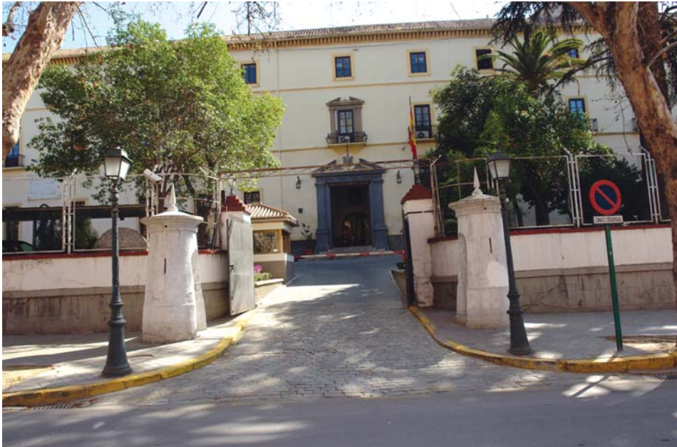
PORTADA DEL ACUARTELAMIENTO DE LA MERCED, SEDE DE LA DIRECCIÓN DE DOCTRINA Y DE LA DIRECCIÓN DE ENSEÑANZA DEL MADOC FOTO: MADOC
